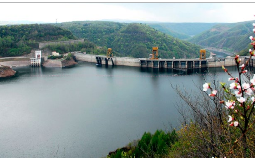
Baishan dam og reservoar i nordøstre Kina, der PSH-Sim er brukt. Foto: ZHANG Zhengping
