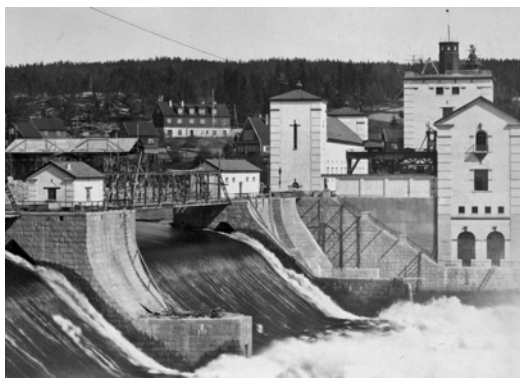
Rånåsfoss – foto: NVE
