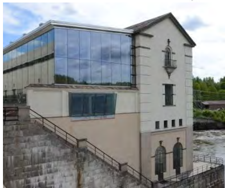
Rånåsfoss – foto: Akershus energi
