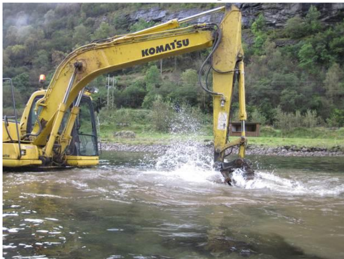
Figur 1 Harving av pakket og fast bunnsbstrat (armeringslag) ndf. E 16 bro 2011.
