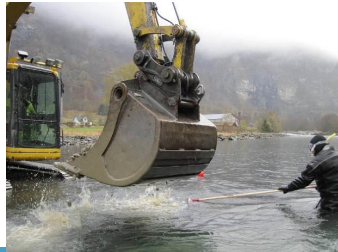
Figur 4 Dykker har utvalgt et egnet sted for grusutlegget og anviser gravemaskin-
