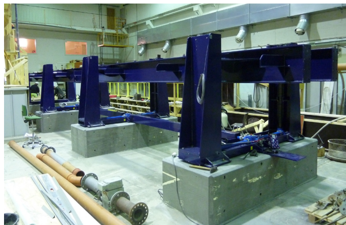
I den nye vannrenna som er under bygging, skal forskerne studere i detalj hva som skjer når vannføringen endres raskt. Foto: CEDREN
