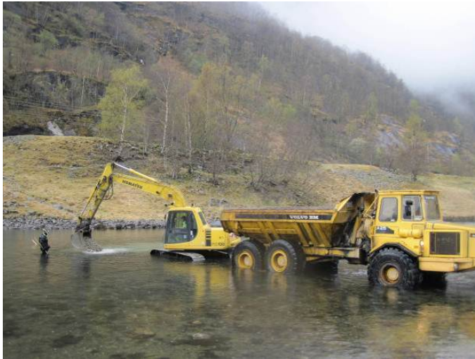
Figur 3 Grusutlegging ved Skaim 2010
