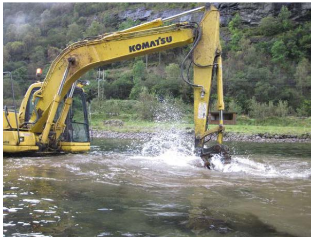
Figur 1 Harving av pakket og fast bunnsstrat (armeringslag) ndf. E 16 bro 2011.
