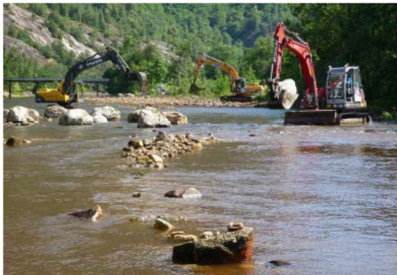
Figur 17. Eksempel på steinutlegging for å skape skjul og et mer variabelt elvemiljø i en homogen og kanalisert elvestrekning. Fra Fra fjordelva i Rogaland). Foto: Ulrich Pulg
