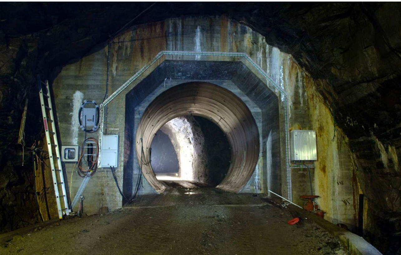
Tverrslagspropp sandfang, Tonstad kraftverk. Foto: Kai-Wilhelm Nessler
